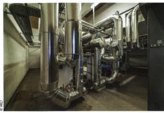
L'ensemble des canalisations sur le circuit NH<sub>3</sub>, mais aussi sur le circuit eau glycolée jusqu'à l'entrée dans les dalles froides et chaudes est en acier inoxydable.
