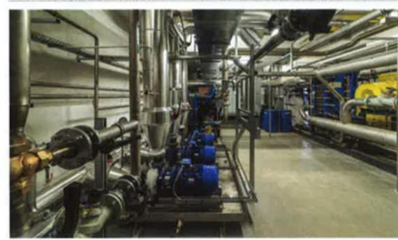
Les huit pompes de l'installation ont été fournies par KSB et sont pilotées par des variateurs de fréquence déportés.
